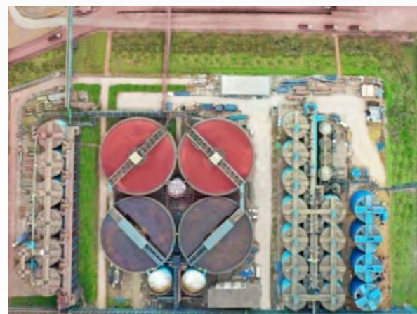
尾矿预处理生产装置
