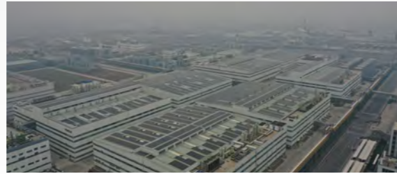
衢州园区分布式光伏项目
