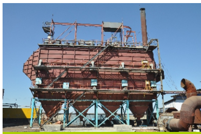
图：公司对鼓风机尾气处理增加电除尘设备，提高烟尘的处理率
