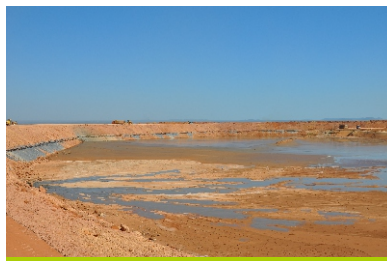
图：公司建立尾矿库并覆膜，防止尾矿库料液下渗，保护周边土壤及地下水环境
