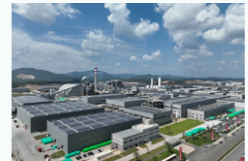
广西基地“源网荷储”一体化项目
